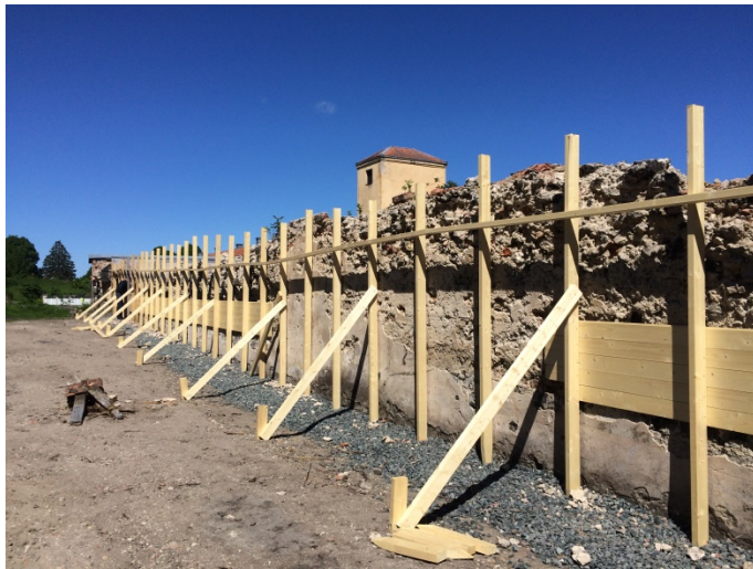
Formsättning förbereds inför stöpgjutning.
