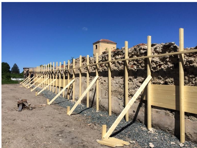
Formsättning förbereds inför stöpgjutning.
