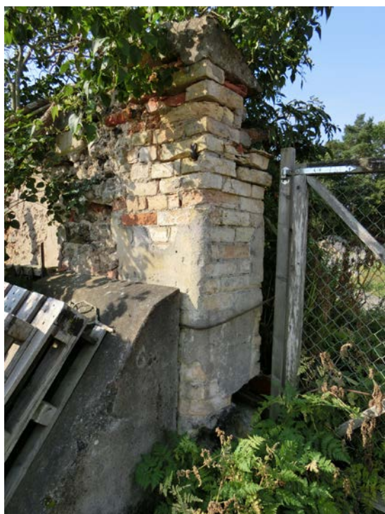
Grindstolparna är murade med handslaget gult tegel. Åtminstone delar av mur- och fogbruk utgörs av cementbruk. Cementkontreforer är gjutna mot stolparna.
