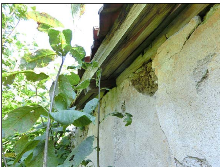
I partier i gott skick finns fortfarande tegeltaket bevarat. Tegelpannorna ligger på bärläkt som vilar på reglar på murkrönet som ligger i takets fallriktning
