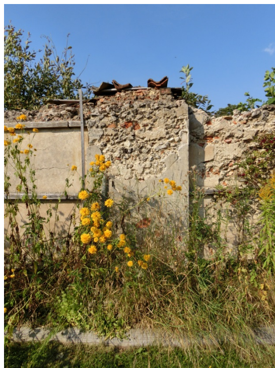
Stöpmuren är utförd omväxlande med kraftigare stolpar och smalare murpartier, allt i samma teknik.
