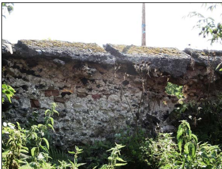
Murkrönet är på vissa delar täckt med en brukskaka med slitsar för reglar.
